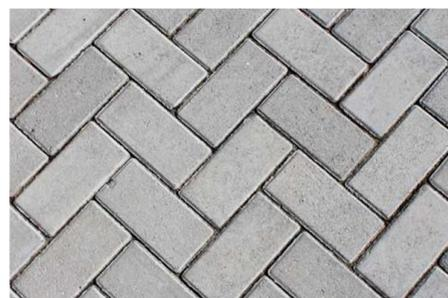
A configuração escolhida para a via será do tipo “espinha de peixe a 45°” com a “espinha” indicando o sentido do tráfego na via (não confundir com a configuração “escama”), conforme imagem acima.
