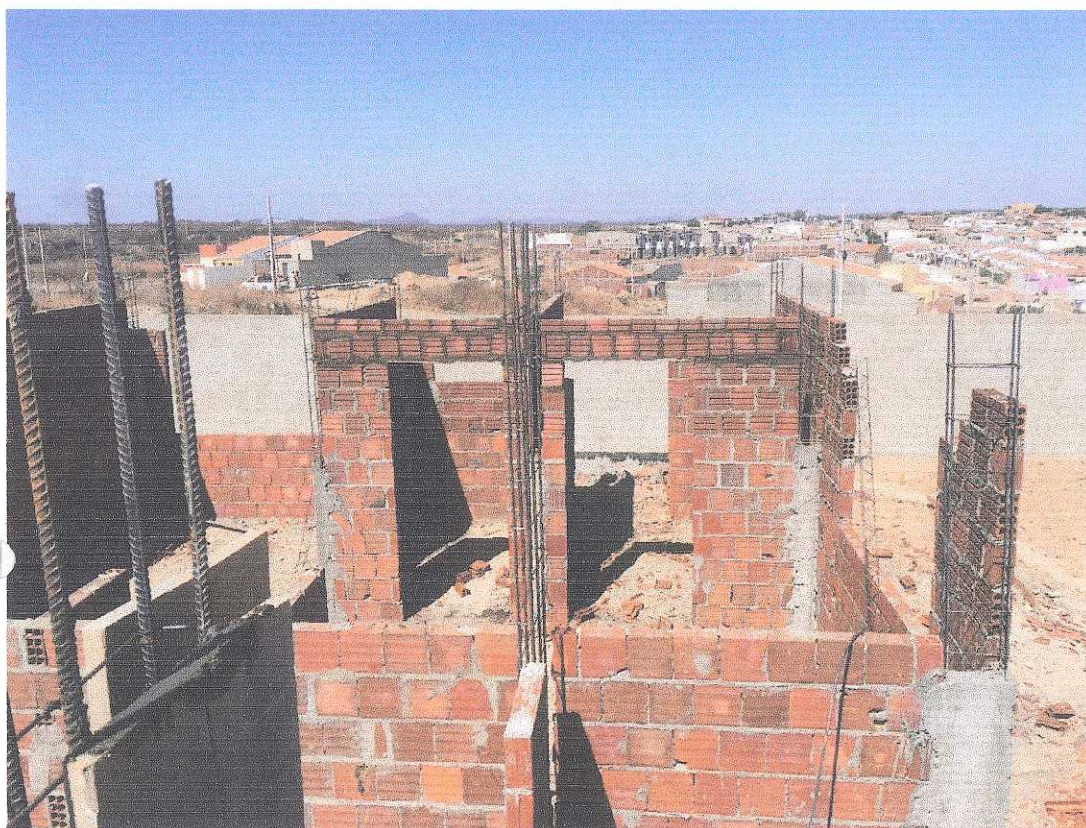
Figura 3: Alvenaria em tijolo cerâmico furado, armação em aço CA-50 e forma para estrutura de concreto.
