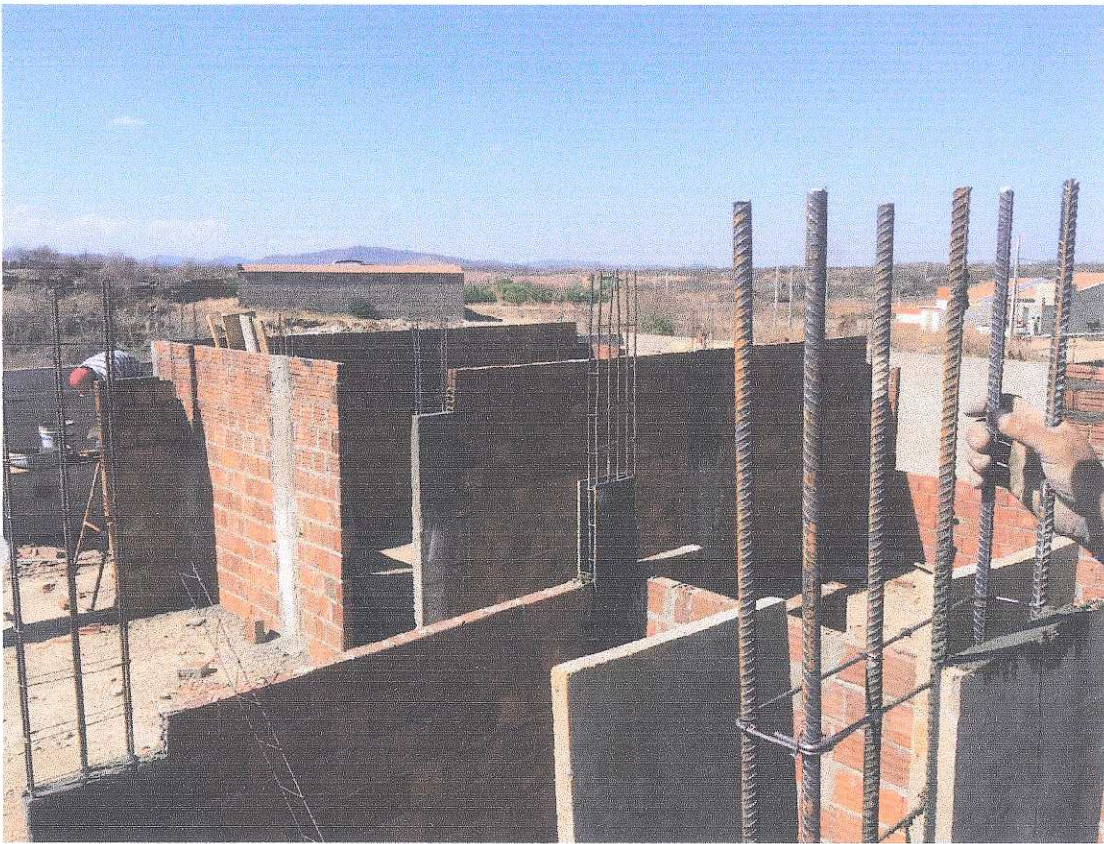
Figura 5: Forma para estrutura de concreto e armação em aço CA-50.
