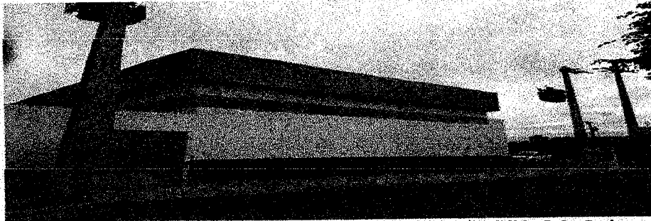
BM 06 - Contrato de Repasse 813175/2014 Ministério da Saúde - Ampliação da Policlínica Orcino Guedes - Cajazeiras/PB (Transformador Elétrico + Pintura Externa da Obra)
