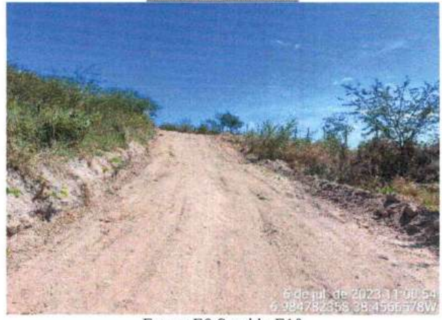
Estaca E9 Sentido E10
